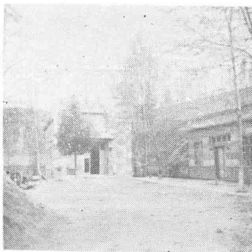
大洪山电站外貌
