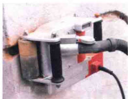
图 1-2 开槽机切槽
