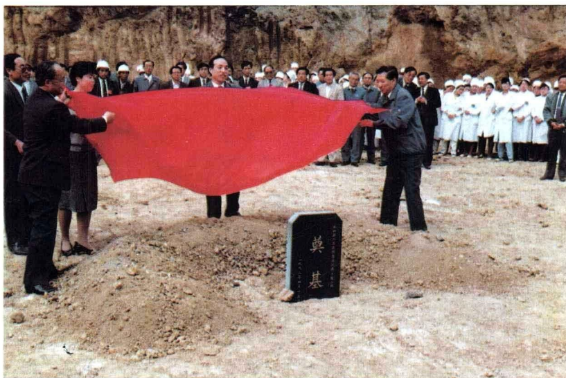
△ 职工总医院 A 楼工程开工
