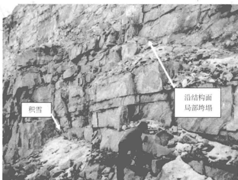
图 1-1 蒙库铁矿边坡冻融诱发局部崩塌
