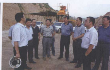
省厅党组成员、省公路局党委书记郭贵平在临离工地现场办公
