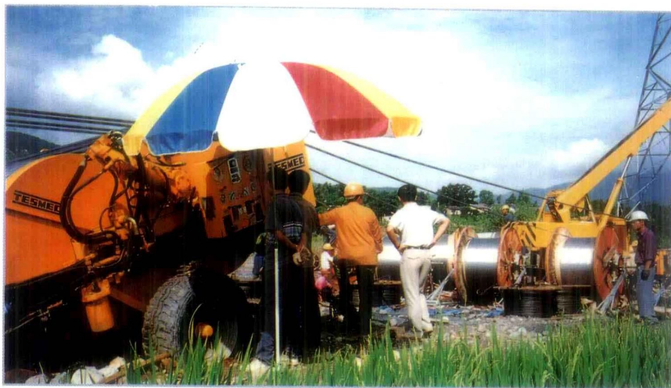
张力放线场一角。
