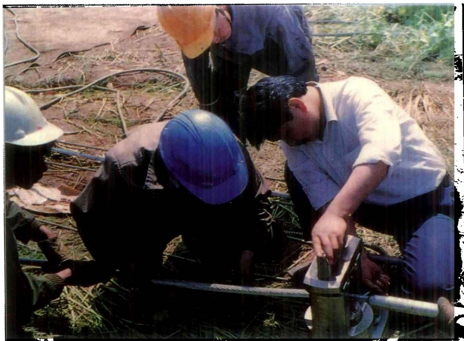
液压压接工艺在线路施工中的应用。
