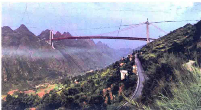
图 1.2 坝陵河大桥全景照(下游侧)
