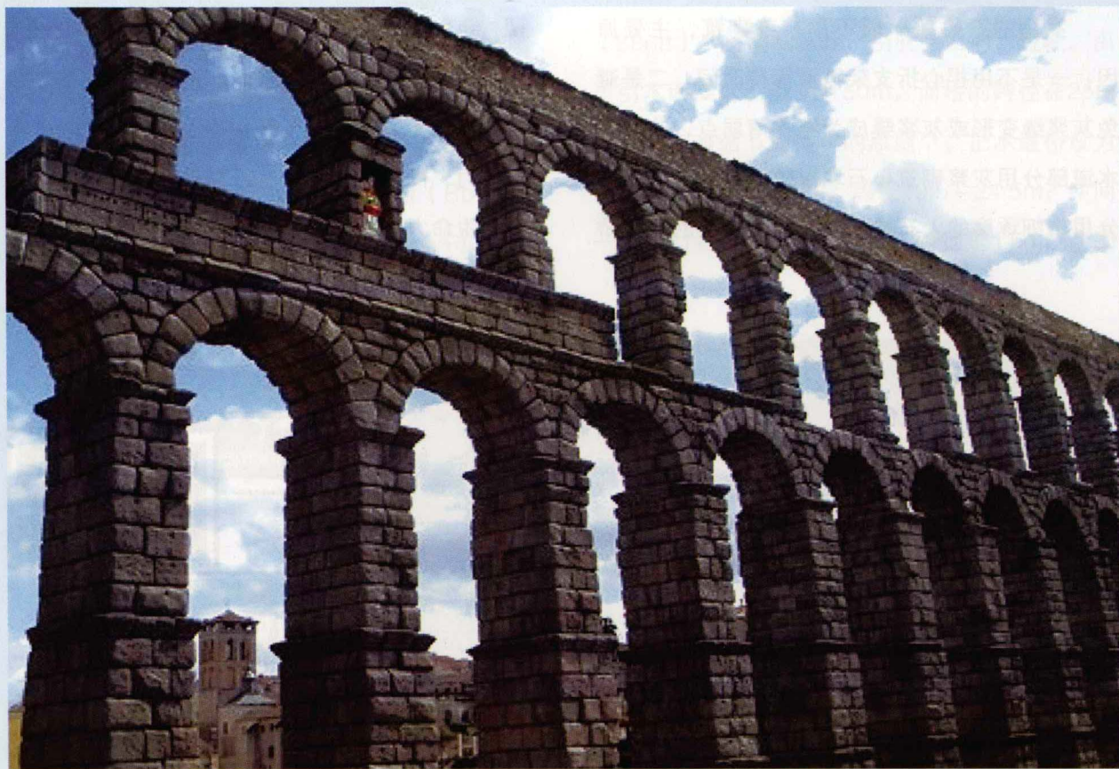
▲ 图1-6 塞戈维亚桥（全用石块砌筑而成，两层高达29m）
