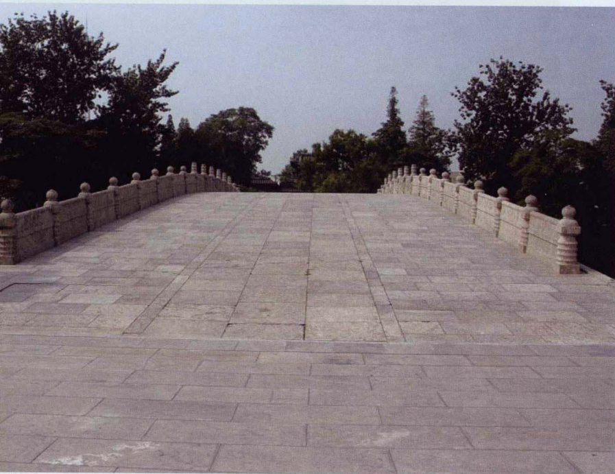
▲ 图4-2 整修后的桥面
