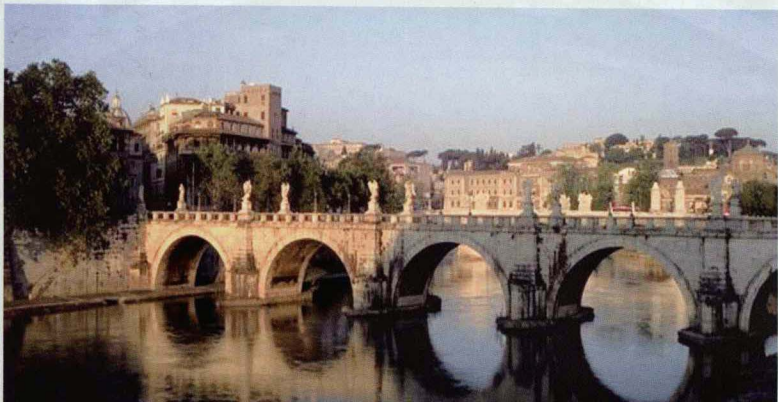
▼ 图3-1 圣安哥勒桥（天使桥）
