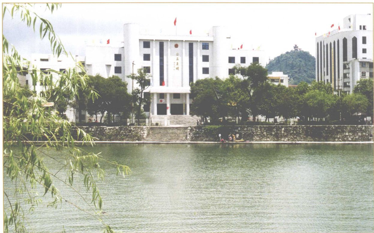
位于都匀市剑江河畔的黔南州中级人民法院办公大楼。
