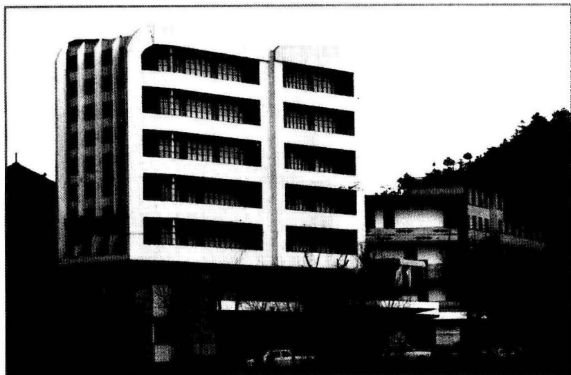
黔南州劳动就业培训 中心大楼
