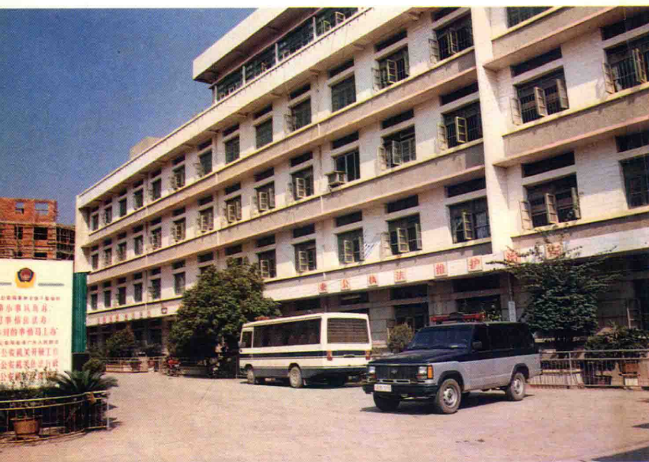
惠安县公安局办公楼
