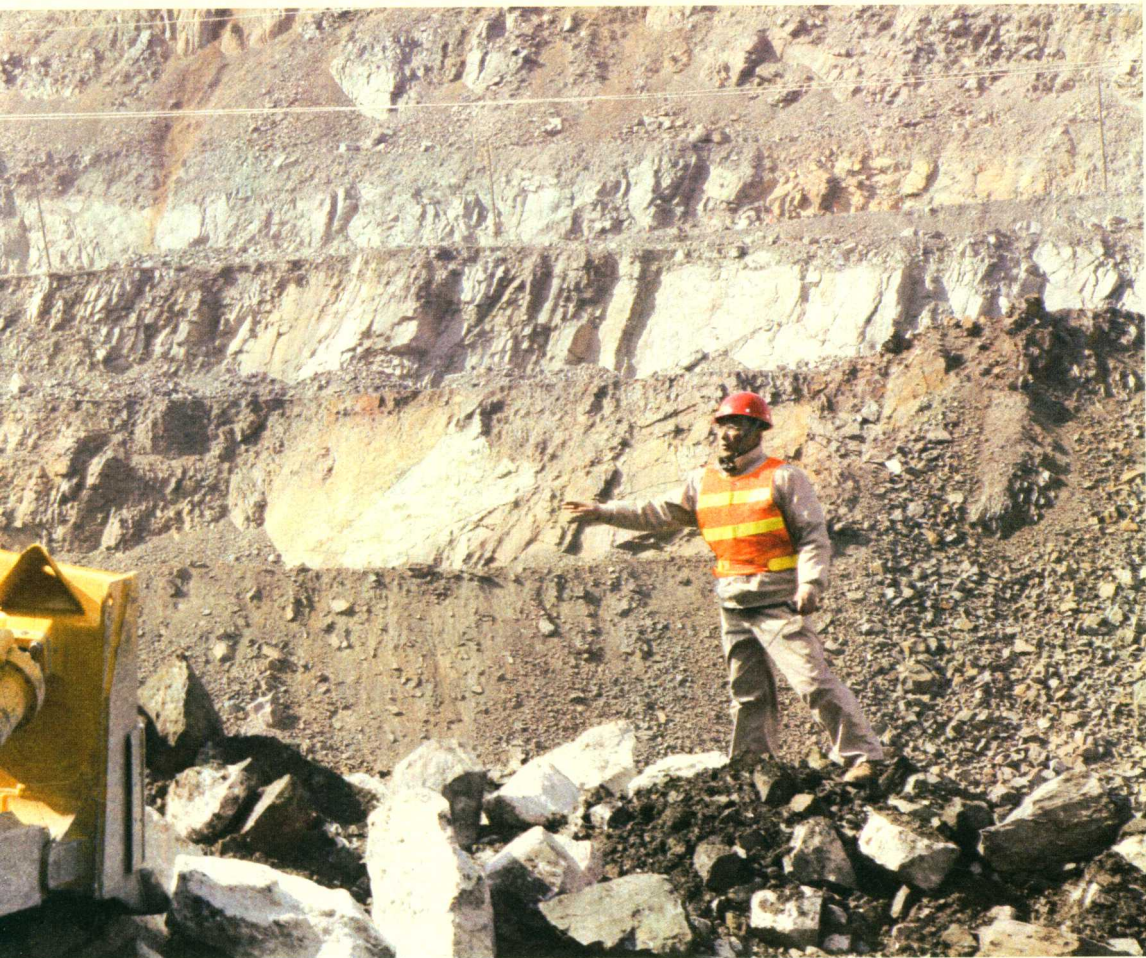
郭明义，1958年12月生，现任鞍钢集团矿业公司齐大山铁矿采场公路管理员。图为郭明义在现场指挥修路作业。
