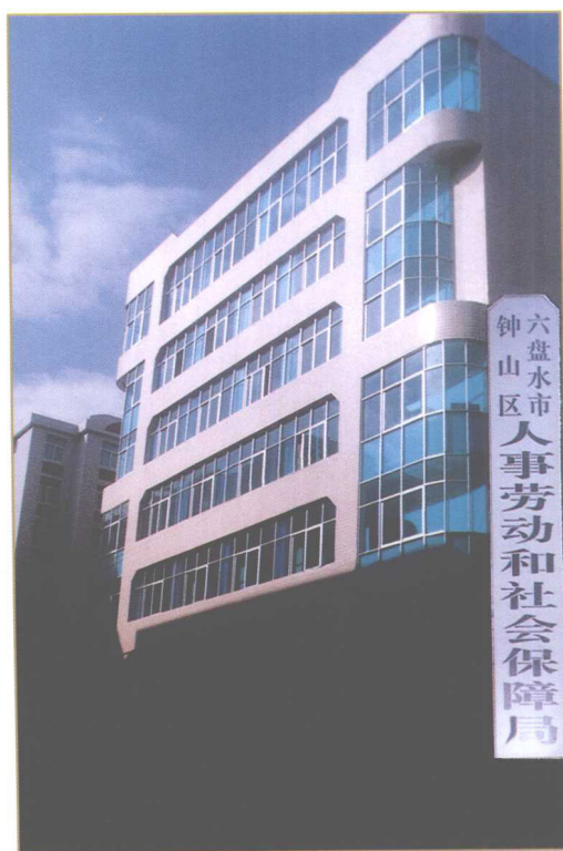
钟山区人事劳动和社会保障局办公楼
