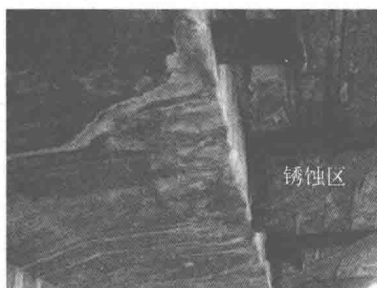
图 1.2 钢筋锈蚀
