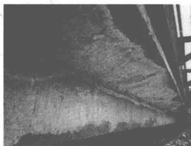
图 1.1 混凝土碳化
