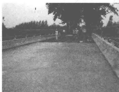
图 1.8 人工整平后桥面
