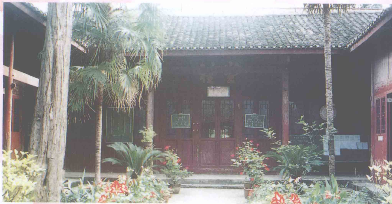
清道光七年(1827年)建于玉屏县城内的印山书院。原址原貌经80年代修葺。(现在玉屏民族小学内)
