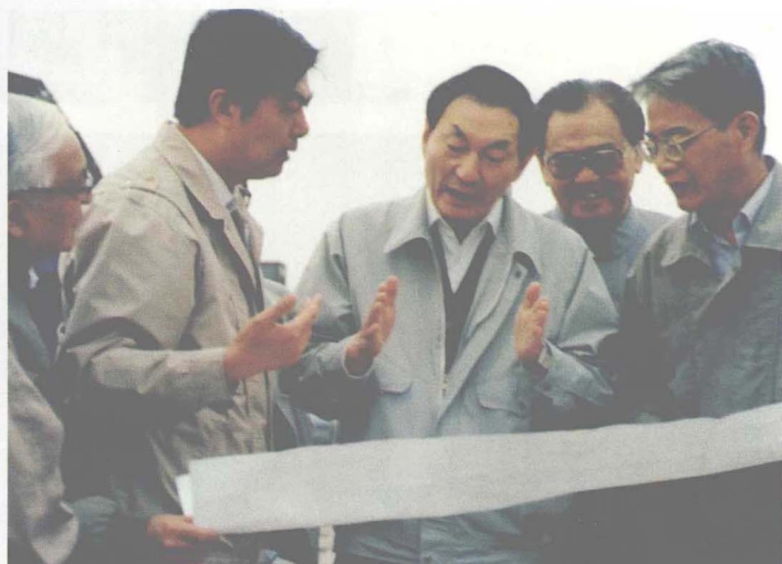
中共中央政治局常委、国务院副总理朱镕基1991年视察九江大桥工地
