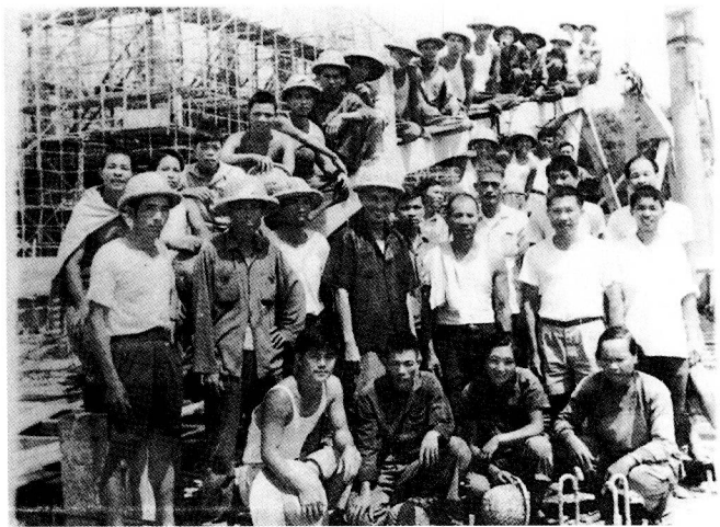
1975 年，李株园（二排左起第四人）在建设平沙二千吨糖厂的工地上
