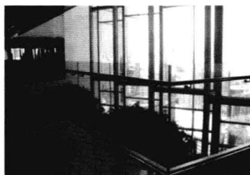
图1-8 承受水平荷载的 玻璃栏板
