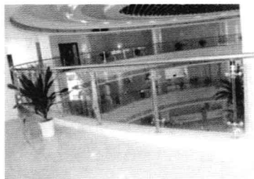
图1-6 室内玻璃栏板 点式安装
