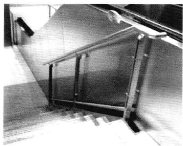
图1-3 室内玻璃栏板 框式安装
