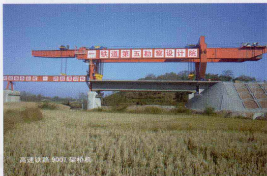
TLJ900型架桥机架设首孔梁
