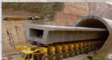
现场运送PC箱梁
