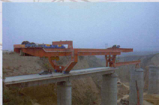
TLJ900型架桥机前移工况
