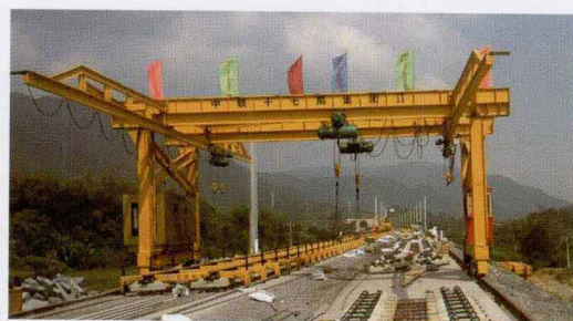
轨行式两点起吊铺板龙门
