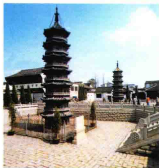
修复后的五代砖塔
