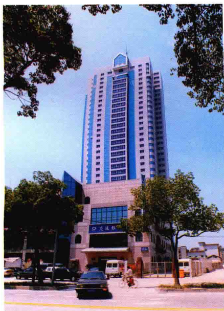
35层的商厦大楼
