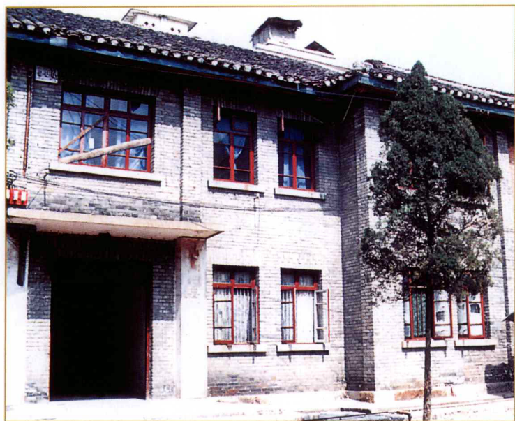
遵义地区中级人民法院 旧办公楼（建于1957年）
