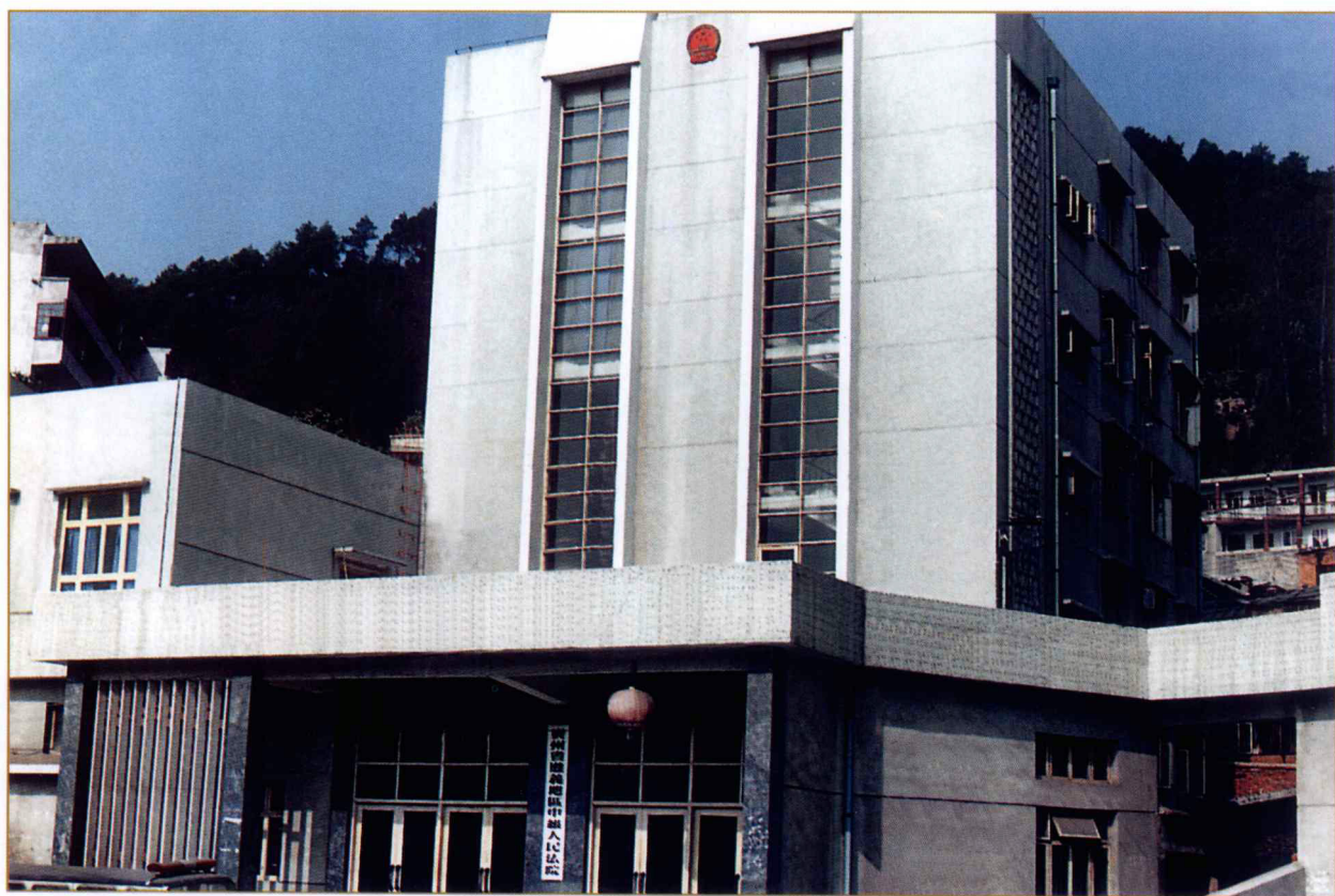
遵义地区中级人民法院办公楼（建于1987年）
