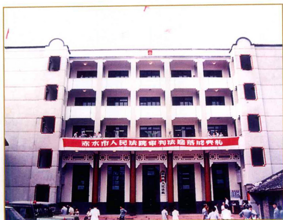
赤水市人民法院办公楼
