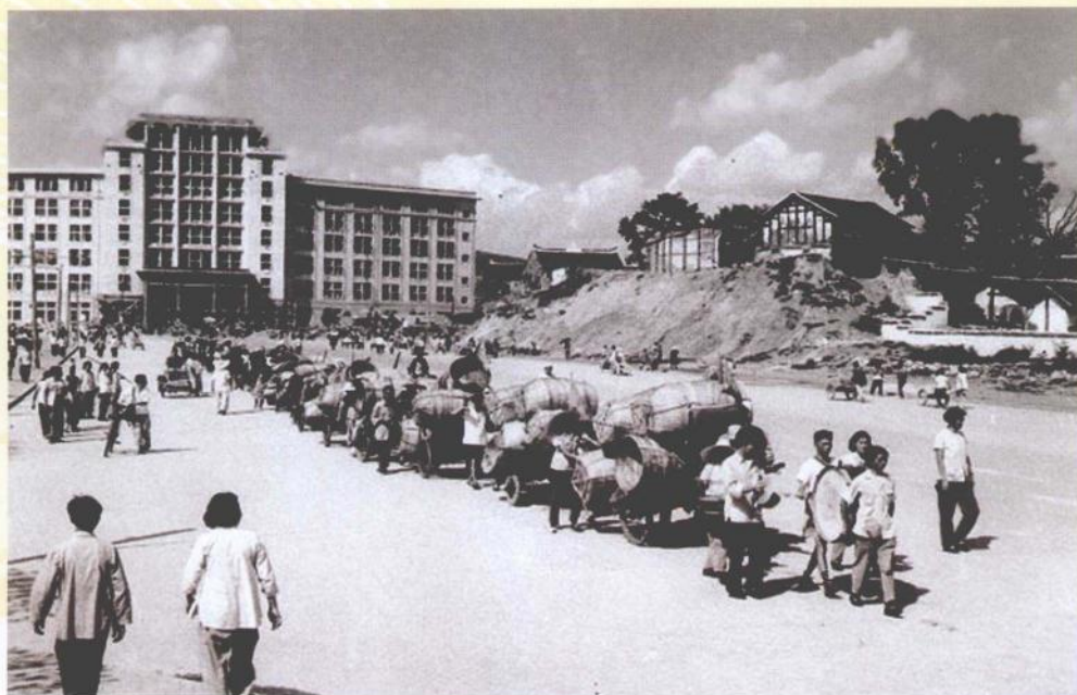
1959年建成的贵阳遵义路
