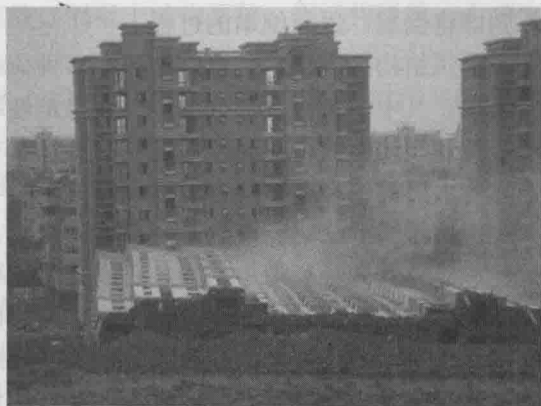
图1-1 上海闵行区莲花河畔景苑整体倾倒事故
