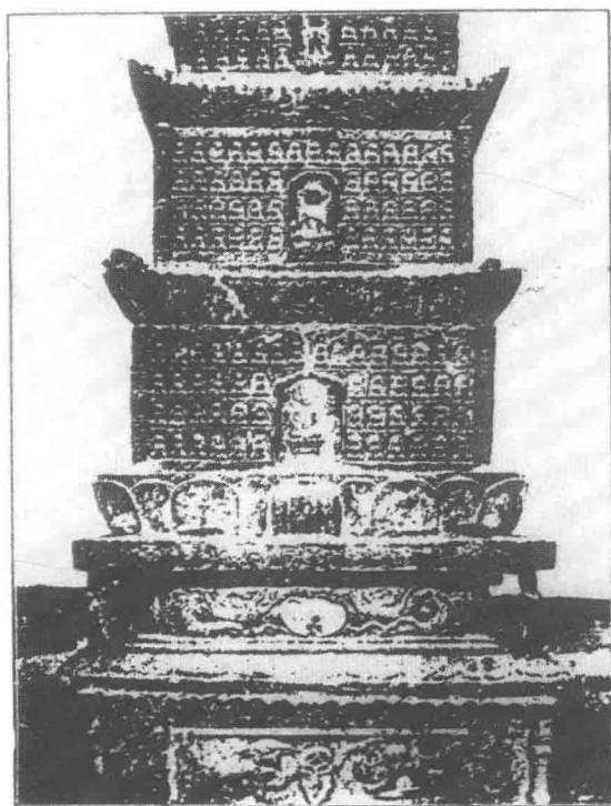
西鐵塔之一面
