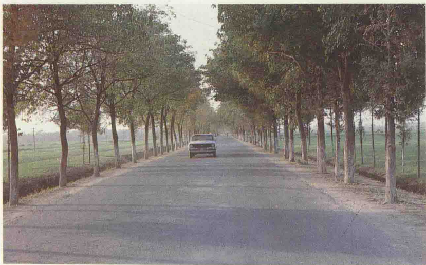
207国道襄阳县境内的绿荫长廊。
