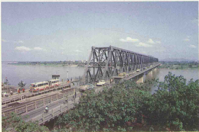
雄伟的襄樊铁公两用大桥。
