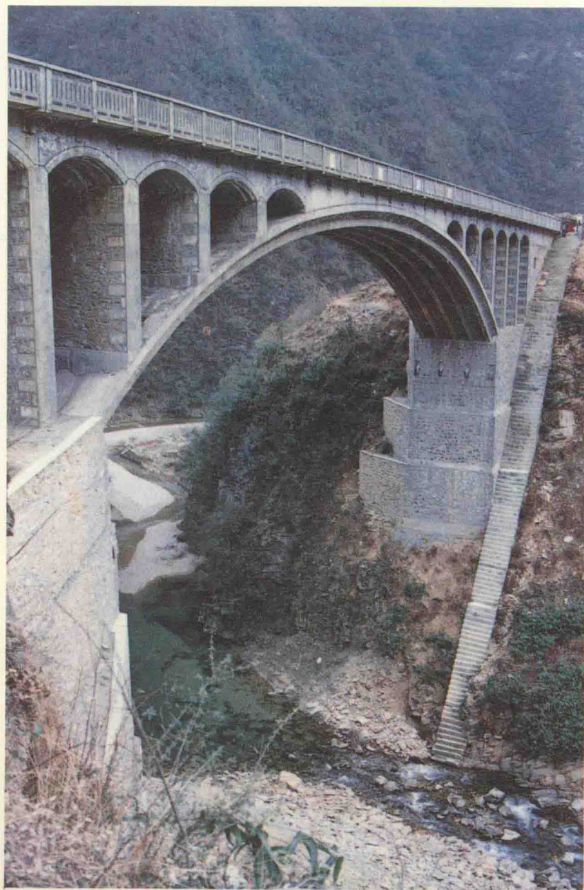
南漳县手板河双曲拱公路桥一孔净跨50米，高42米，为全市第一座高桥。
