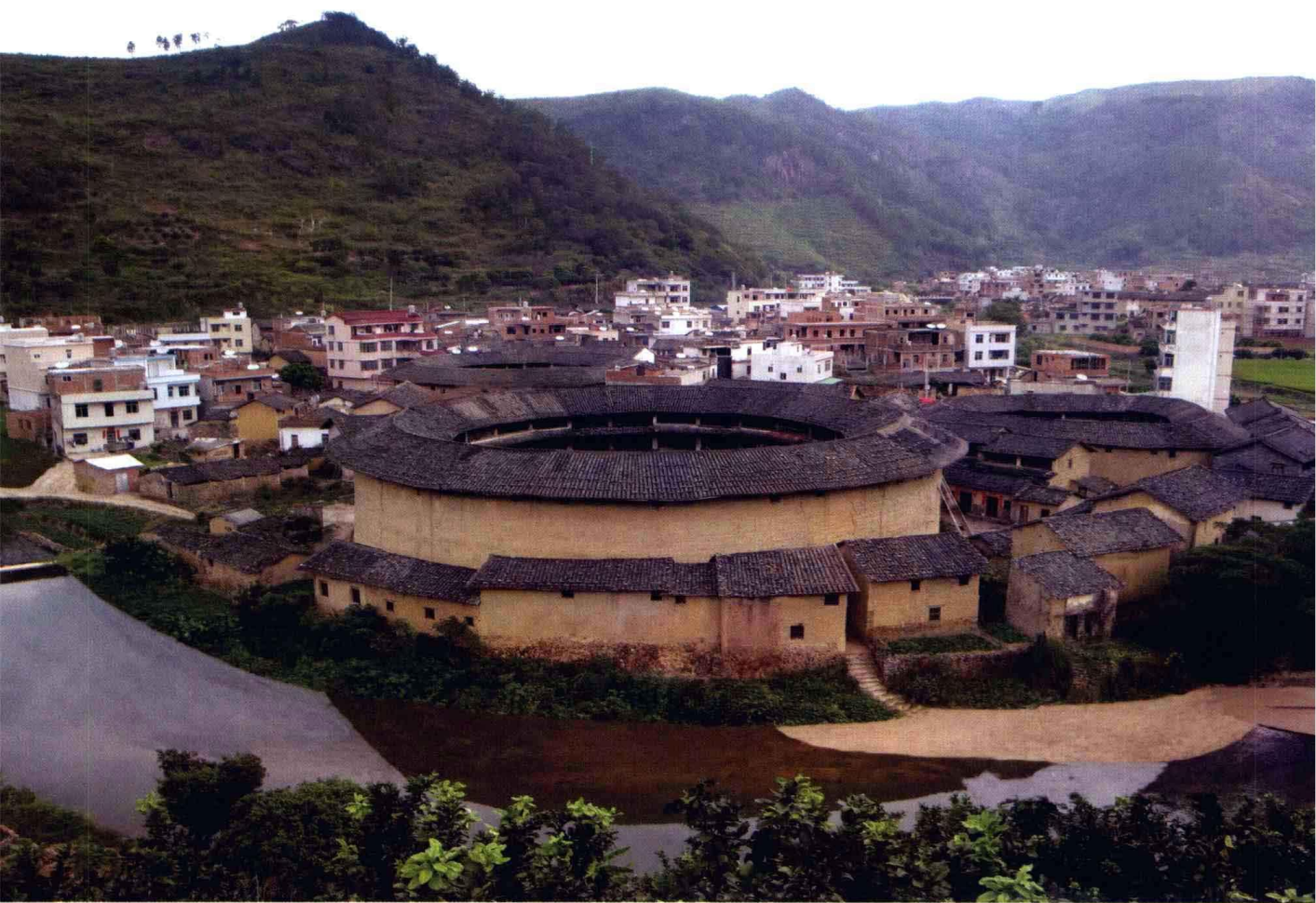
饶平土楼——南阳楼
