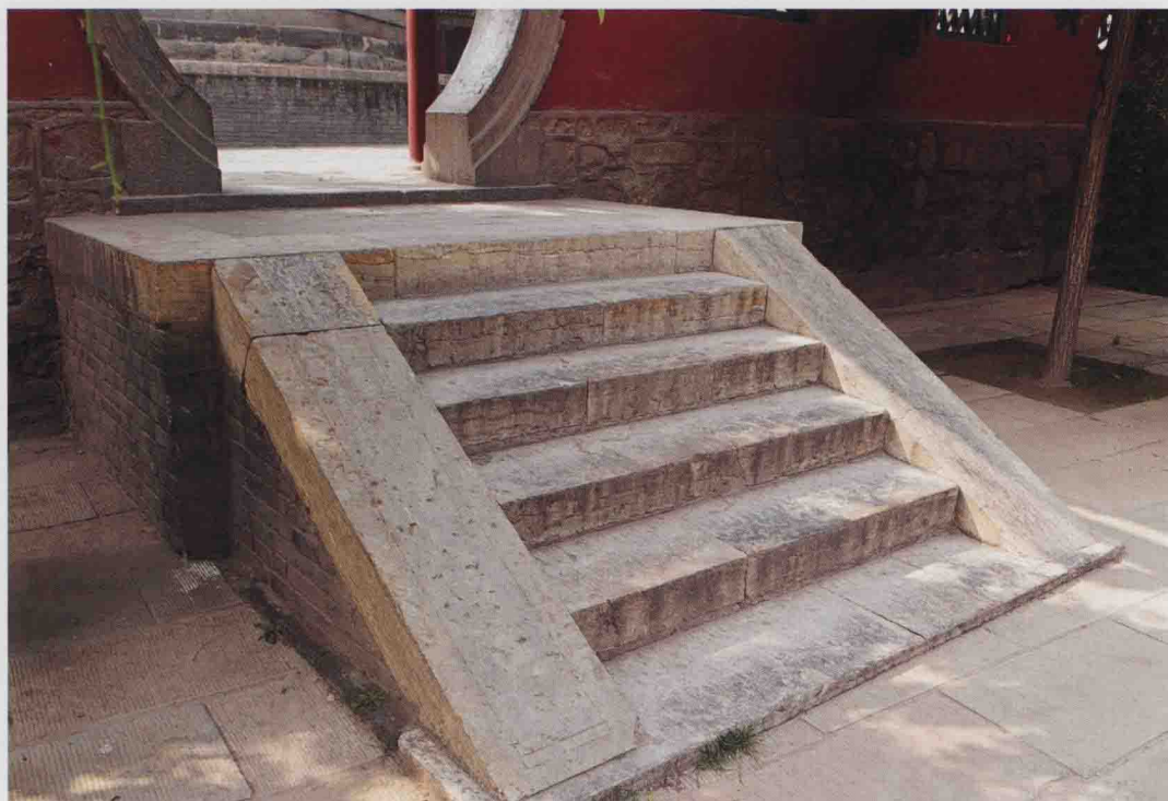
晋祠浮屠院踏跺
