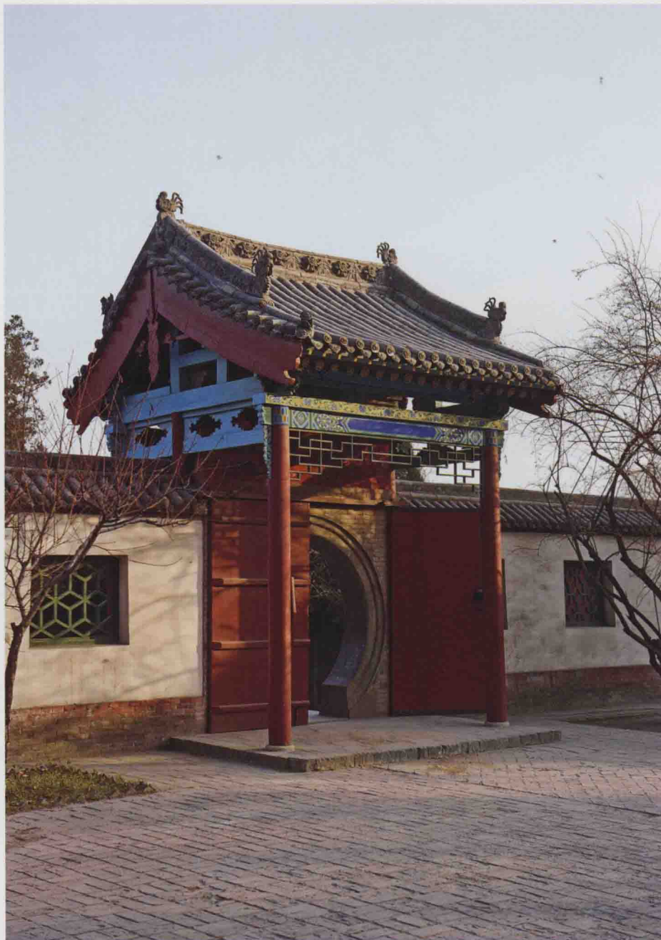
晋祠浮屠院门背立面
