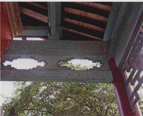
晋祠浮屠院后檐梁架
