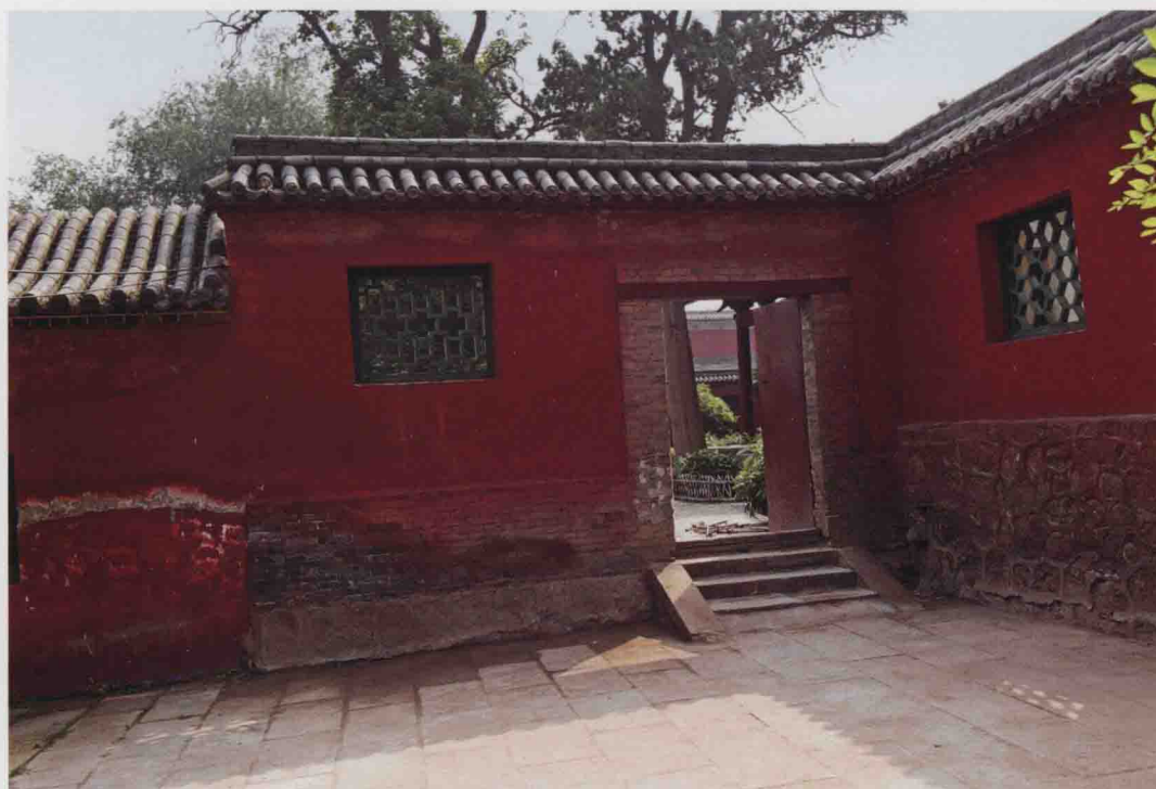
晋祠浮屠院侧门
