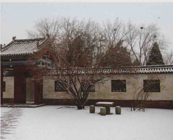
晋祠浮屠院门背立面
