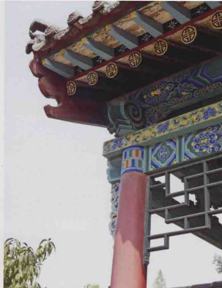
晋祠浮屠院门后檐檐口
