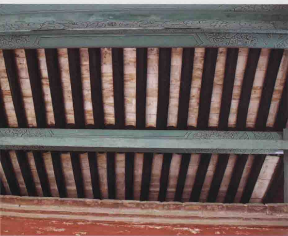
晋祠浮屠院大门梁架
