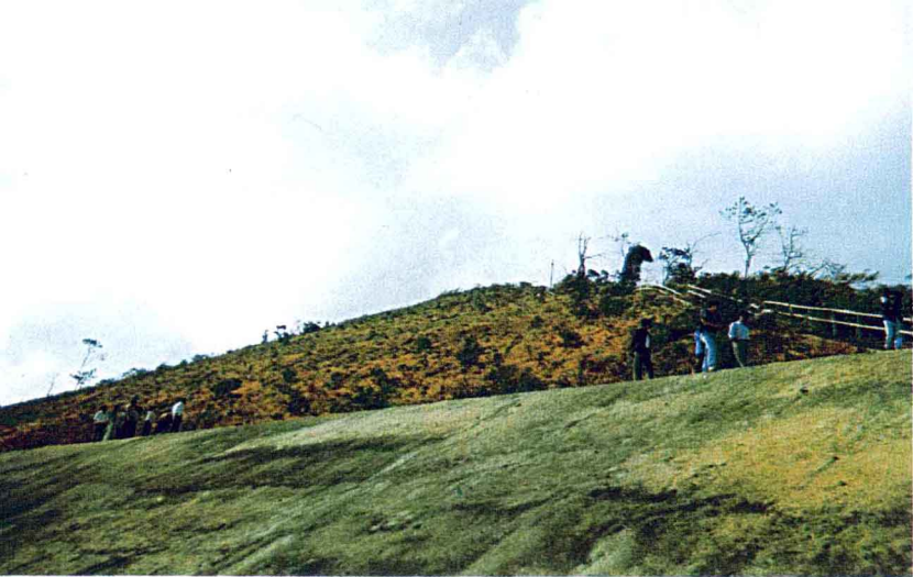
▲ 利用液压喷播技术建成的护坡草坪
