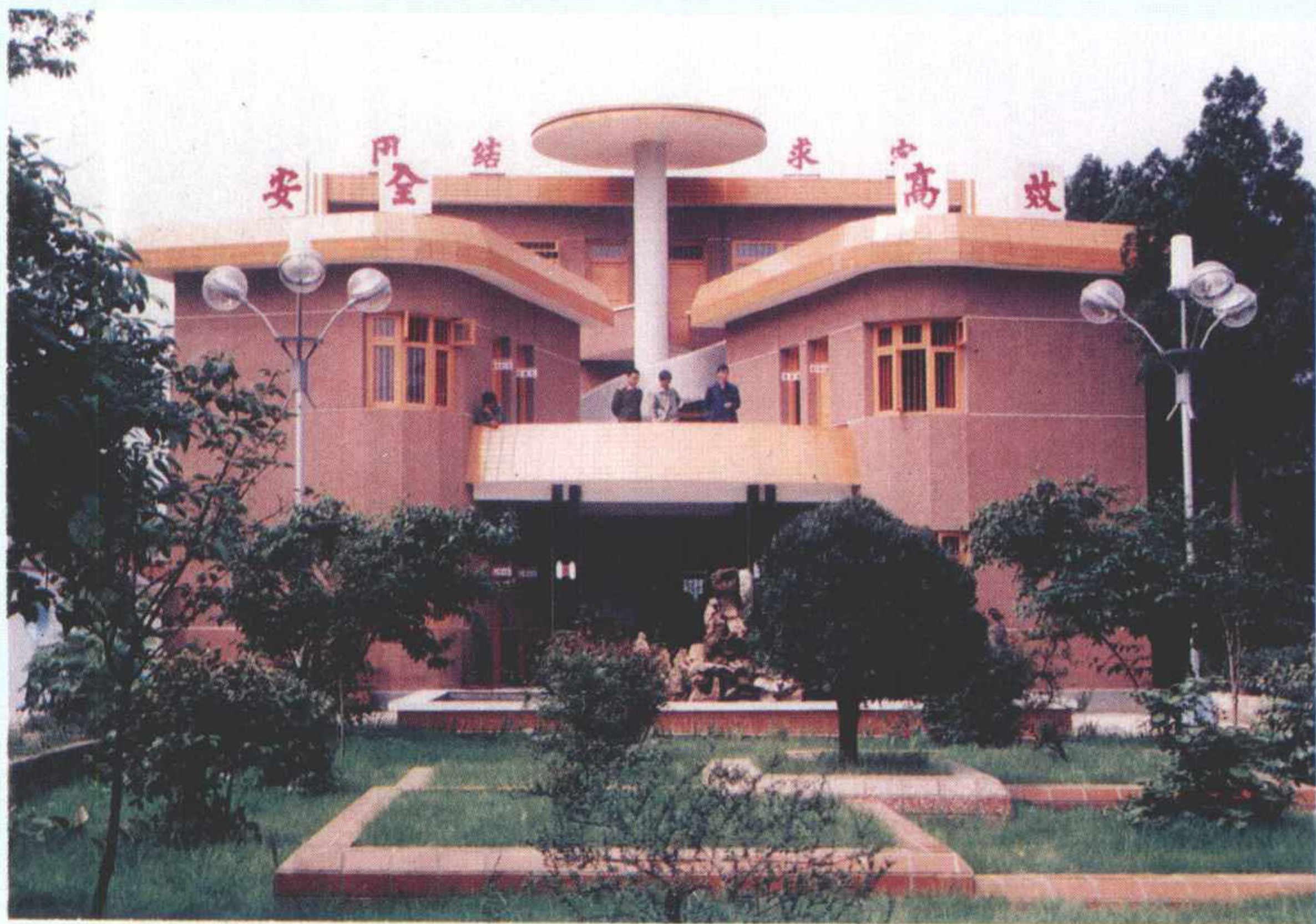
修文电站办公楼
