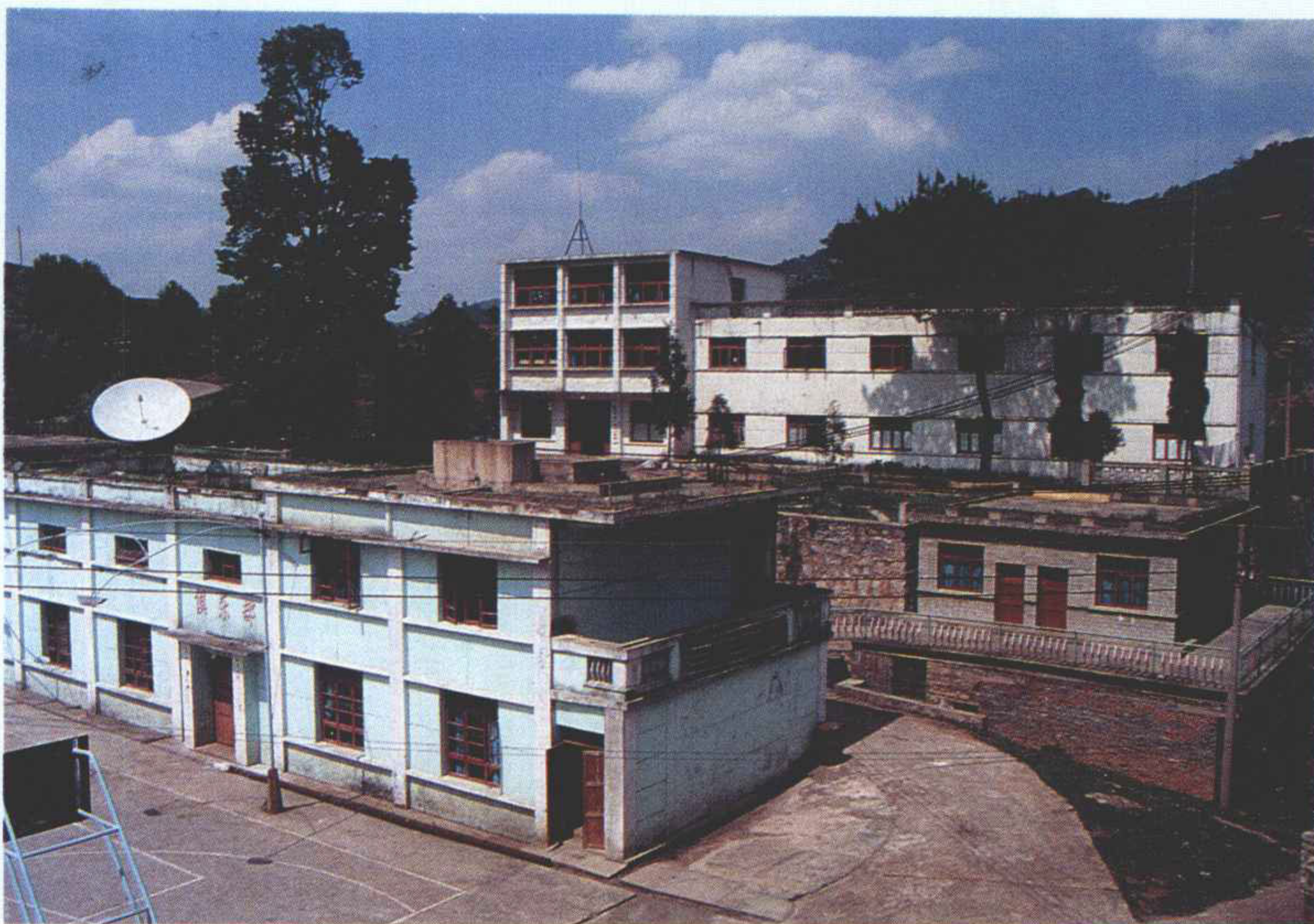
窄巷口电站办公楼
