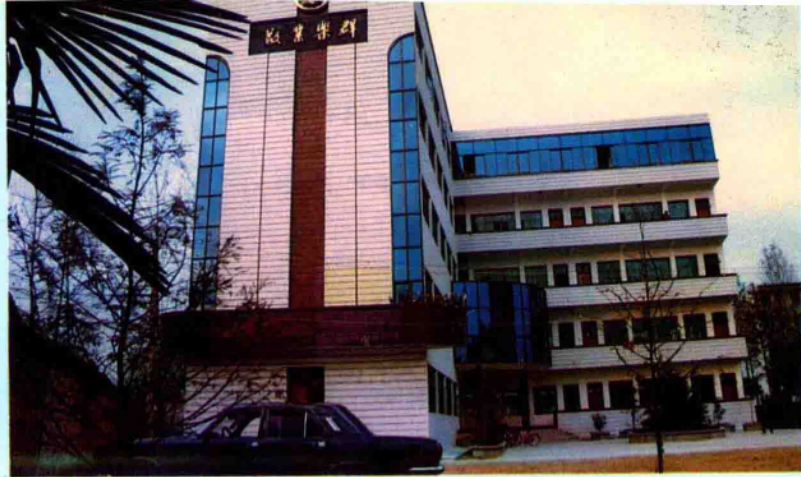
随州电大、职大教学大楼
