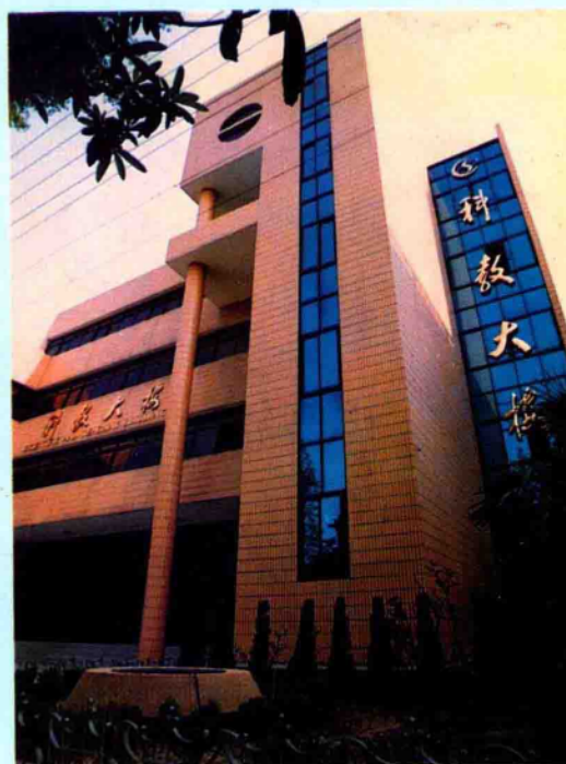
随州市第一高级中学科教大楼
