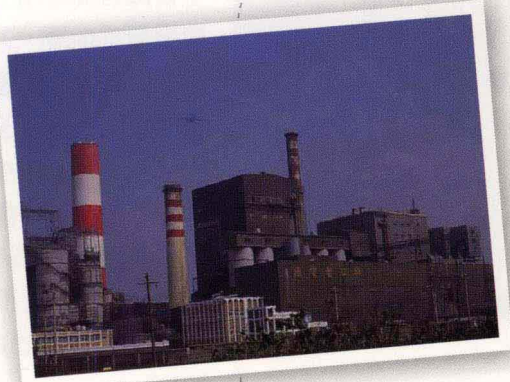
↑ 林口火力發電廠的發電機能源為煤炭。
