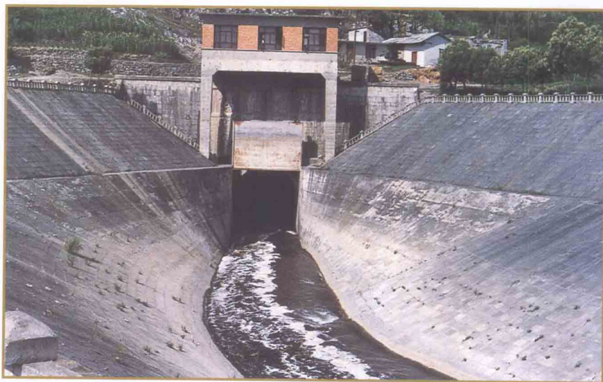
桐梓县天门河排洪隧洞
