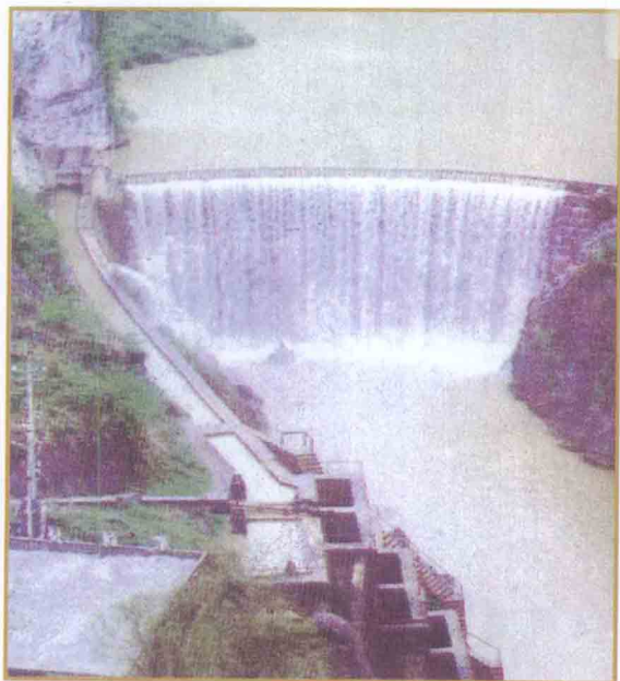
全国扬程最高的水轮泵站——遵义县新民水轮泵站
