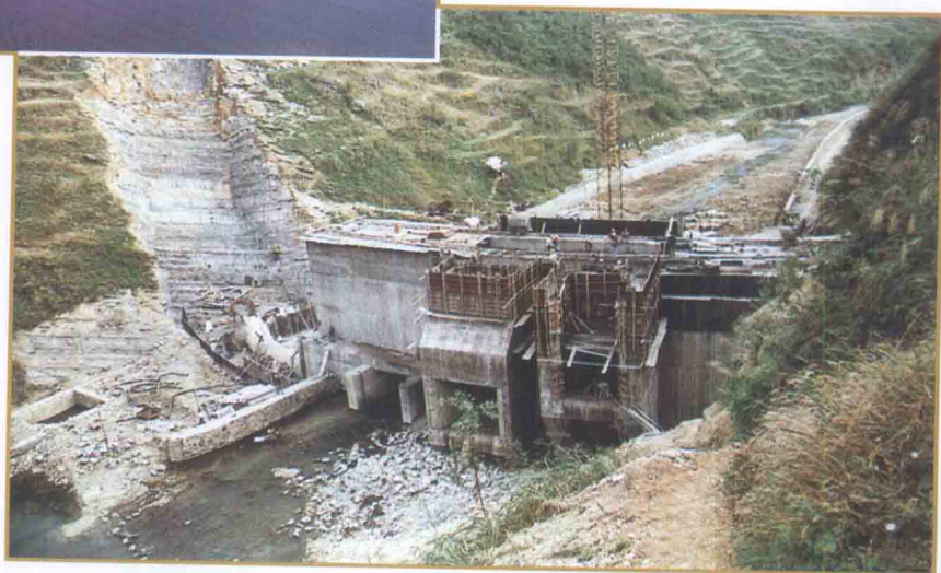
施工中的海龙水库
