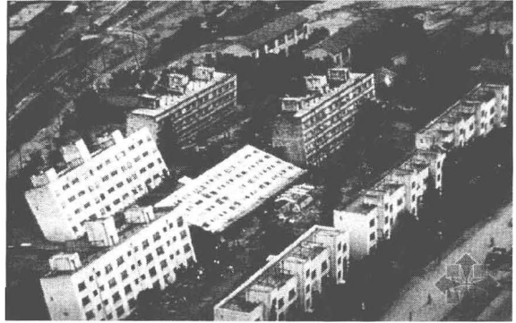
图 1-10 地基失效引起建筑物倾斜、倒塌
