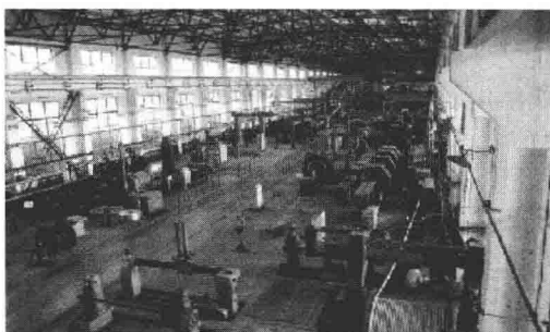
图 1-1 电线电缆工厂实景
