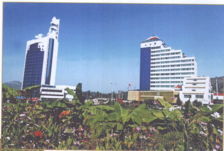
盘江煤电(集团) 公司机关办公楼及职 工培训中心
