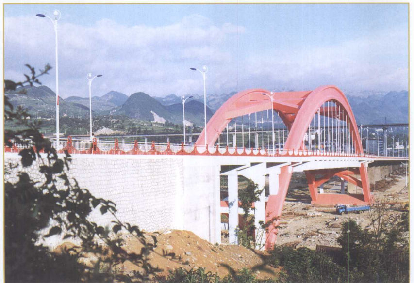
新建成的白鹤高架桥
