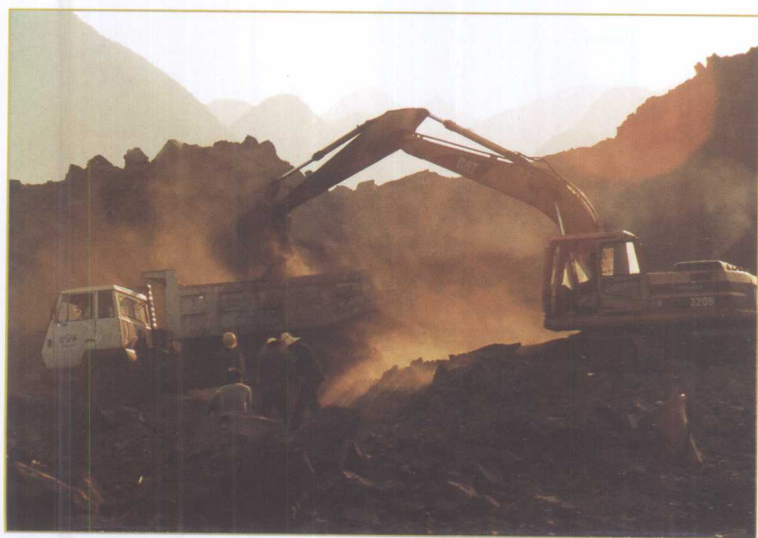
六盘水南站前期施工现场
