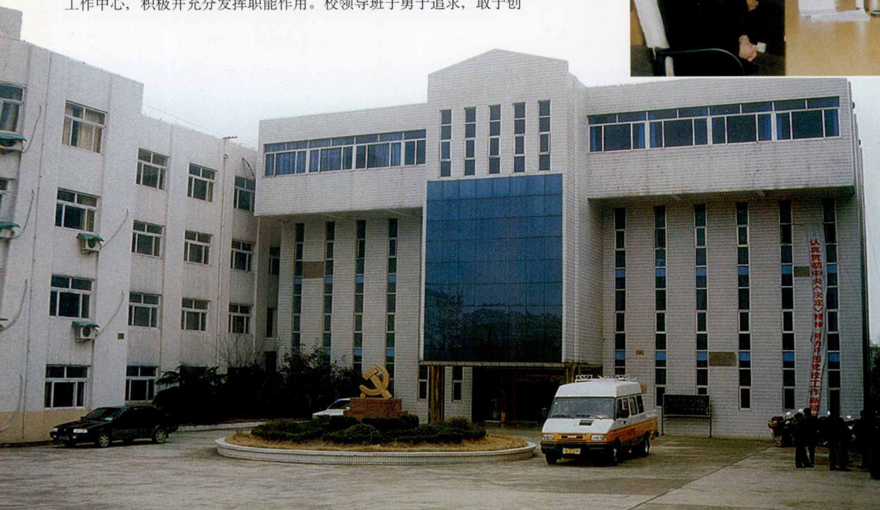
教学办公大楼
