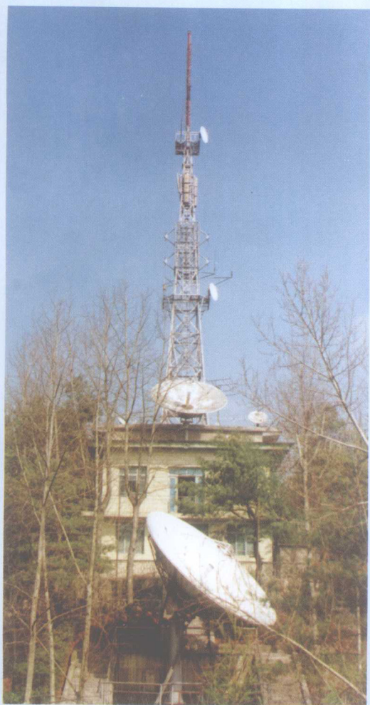
▲ 毕节地区电视台发射机房及铁塔
