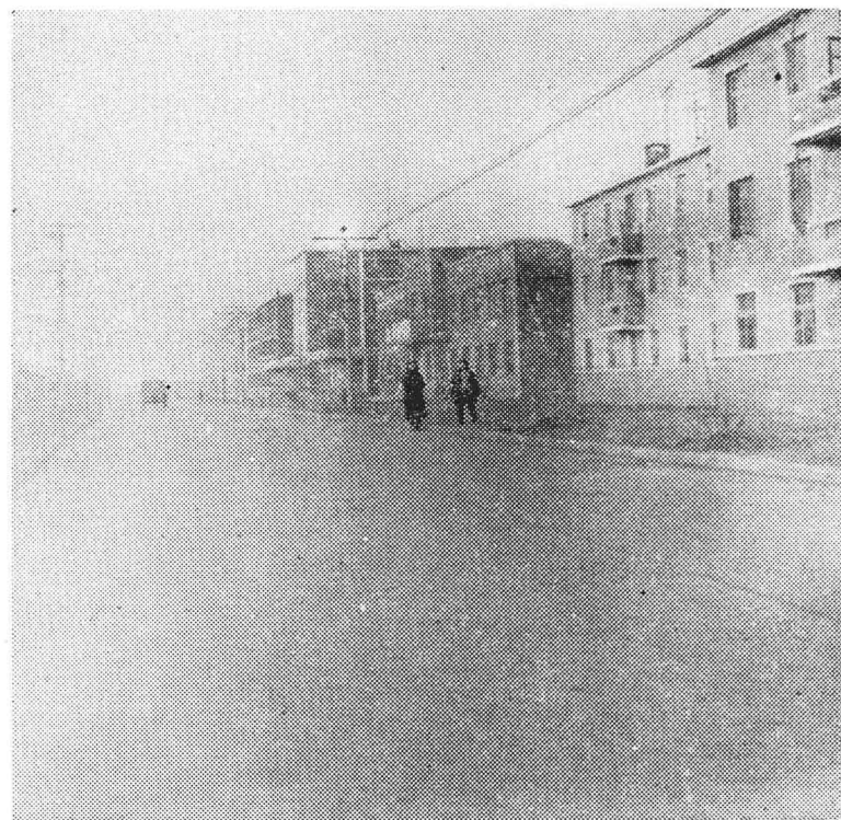
新兴的电力村镇——太平湾
