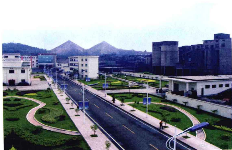
丰城矿务局建新煤矿井口工业广场
