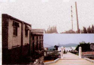
■ 第一座洋桥升压站
