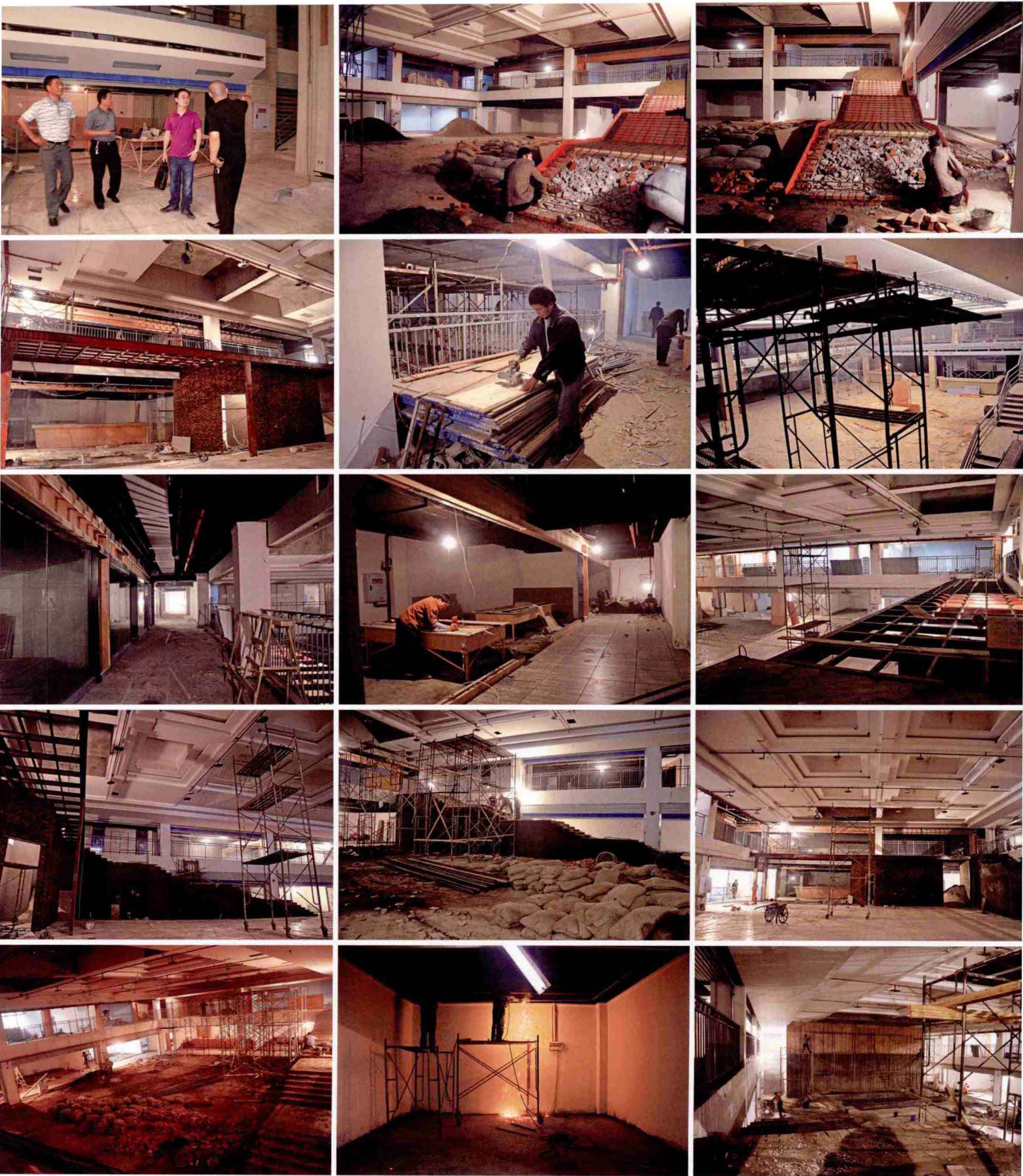
渝澳国际艺术中心建设施工现场
