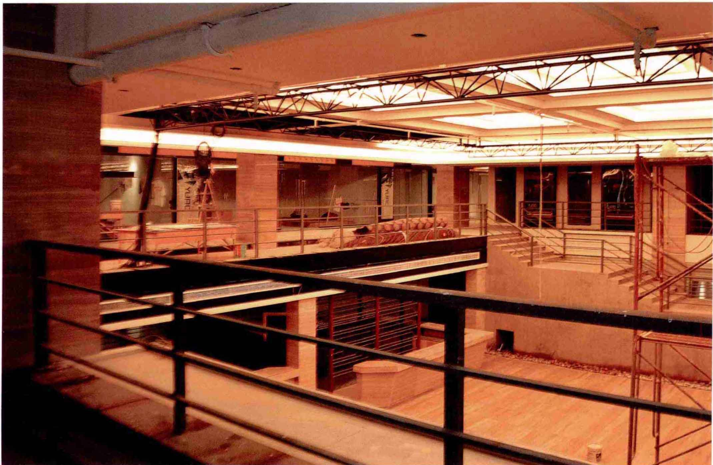
渝澳国际艺术中心建设施工现场
