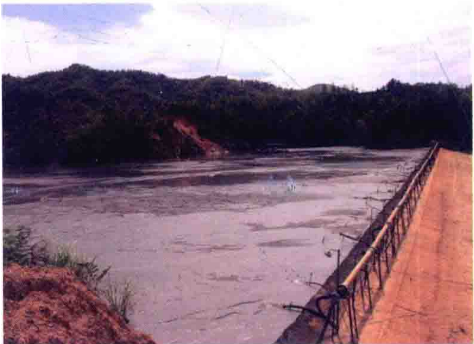
图 1.22 下鲍矿区尾砂库
