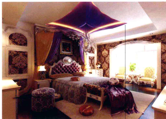
石膏板造型顶棚
