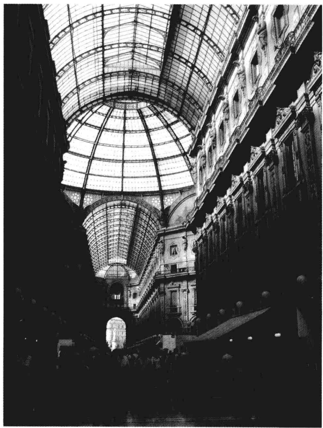
图1-2 现代玻璃拱形顶棚与古典建筑形式结合突出技艺之美
