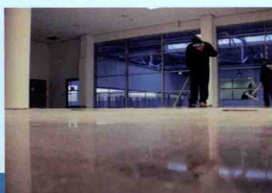
Step 3, Levelling & cleaning 第三步，找平及清理
