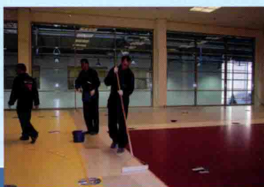
Step 5, Topcoat 第五步，聚氨酯面漆施工
