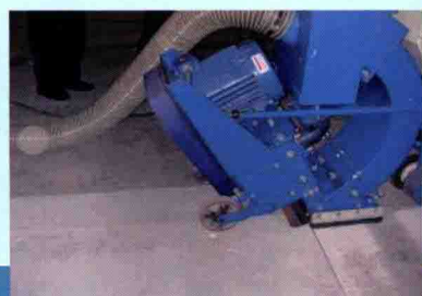
Step 1, substrate preparation 第一步，基层处理
