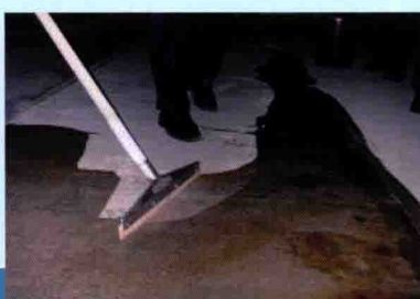
Step 2, Primer 第二步，底漆施工
