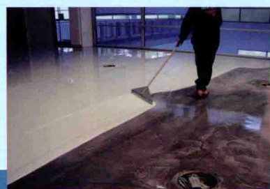
Step 4, PU self-levelling 第四步，聚氨酯自流平施工
