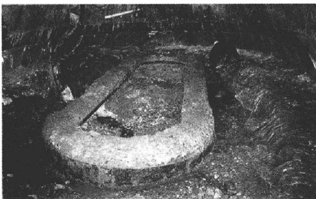
图 1-7 气压沉箱工作室内清除原有桥梁基础
