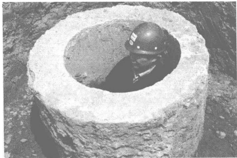
图 5 PCC 桩的开挖检测
