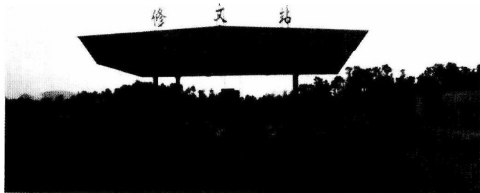
2000年竣工的贵遵公路修文进出口。
