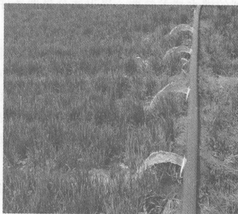
图6 田间闸管灌溉系统运行
