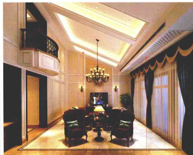
石膏板造型暗藏灯带
